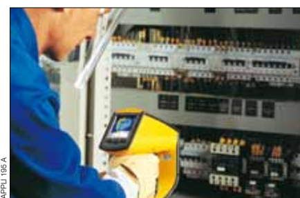
Inspección del panel de distribución
